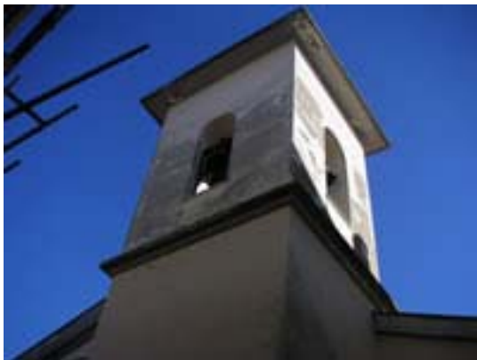
Foto 2 - Campanile Chiesa S.Silvestro
