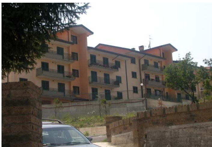
Foto 9- Interventi di Edilizia residenziale pubblica a Cesinali
